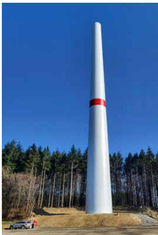
In Bau befindlicher Windpark Dünfus
